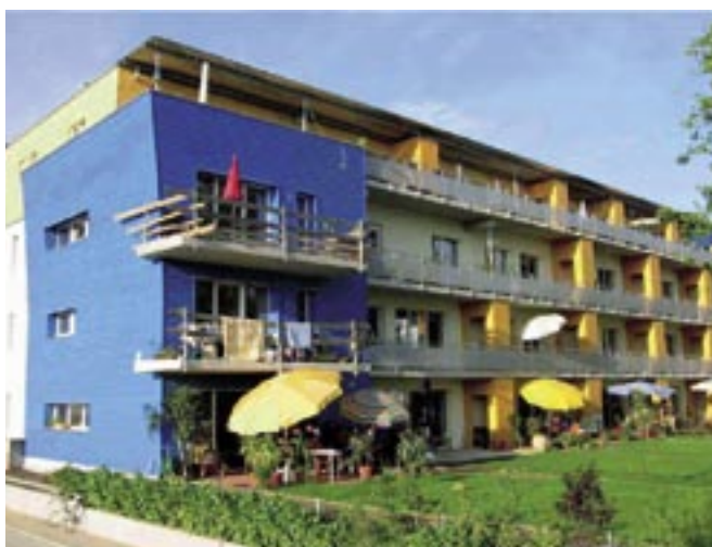
Obr. 2 Pasívny bytový dom vo Freiburgu, Nemecko
