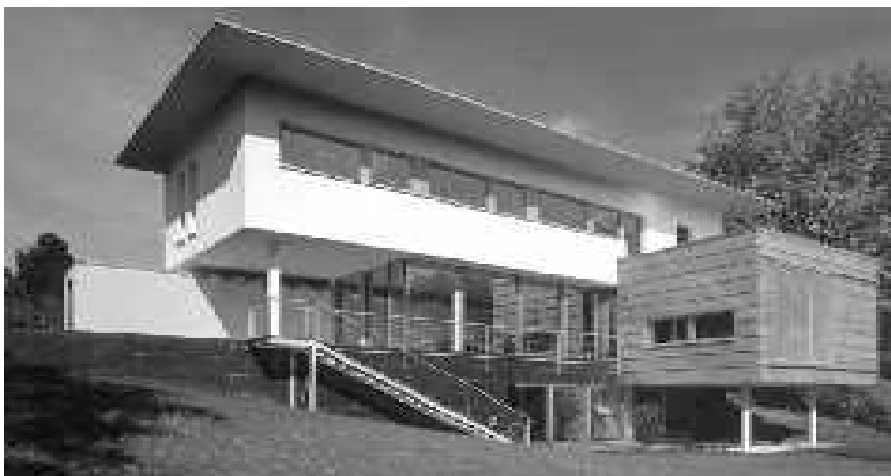
Pasívny dom v Steyri (arch. Proyer).
