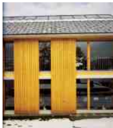
Okná nízkoenergetických domov nebývajú zbytočne členené - dominuje sklo, nie rám (pasívny radový dom v Eggu, arch. Fink&Thurnher)
