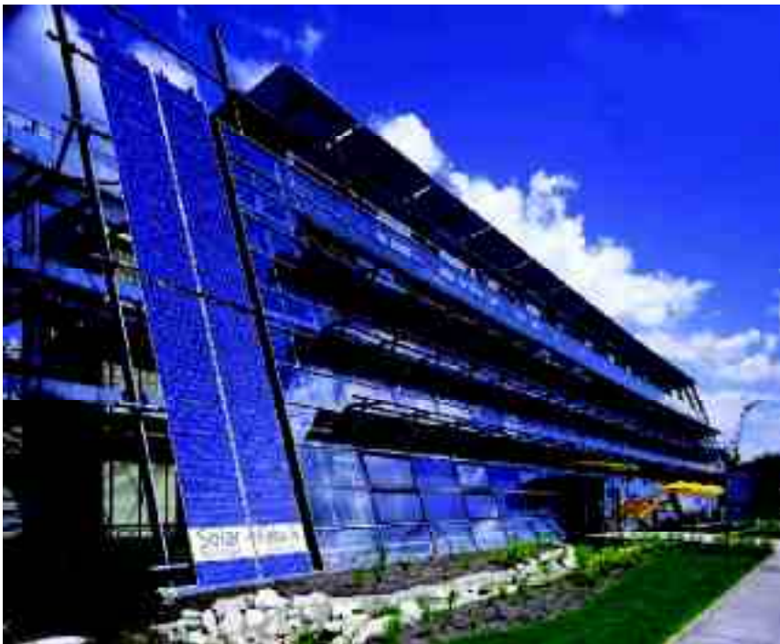
Presklená fasáda továrne na výrobu solárnych panelov demonštratívne využíva energiu Slnka (budova firmy Solarfabrik, Freiburg)
