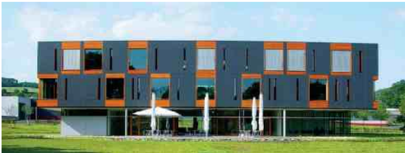
Mnohé nízkoenergetické domy zaujmú aj dizajnom svojich zasklení - požiadavka efektívnosti je skôr inšpiráciou než obmedzením (nízkoenergetická administratívna budova Sägewerk Pollmeier v Kreuzburgu)
