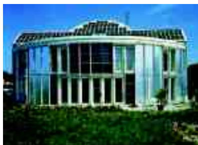
Južná fasáda „nulovoenergetického“ experimentálneho domu vo Freiburgu slúži na zachytávanie energie Slnka (energeticky sebestačný dom, Freiburg, arch. Rolf Disch)
