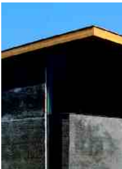
Bezrámové pevné zasklenie je efektívne a efektívne zároveň (nízkoenergetický dom vo Wolfsthal, arch. Martin Kvasnica)
