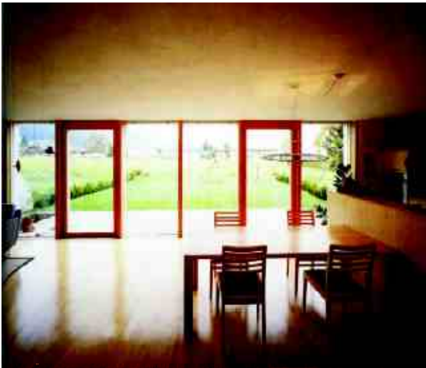
Okná prepájajú interiér s exteriérom - aj zasklená stena môže mať dostatočnú izolačnú schopnosť, keď pevné zasklenia minimalizujú plochu rámov (pasívny radový dom v Horbranzi, arch. Richard Caldonazzi)
